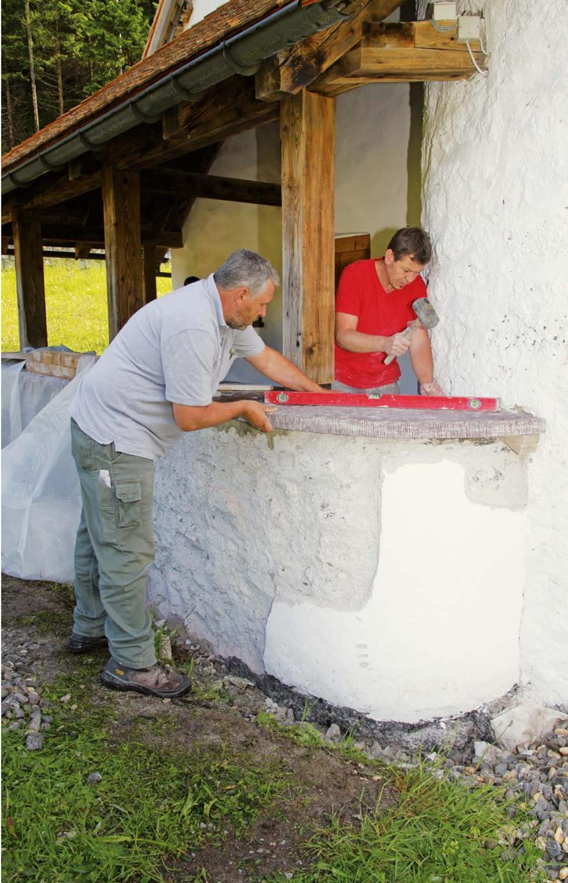
*Mit dem Setzen der Eckplatte und den Gipsarbeiten der Brüstung konnte die Renovation erfolgreich abgeschlossen werden.*
